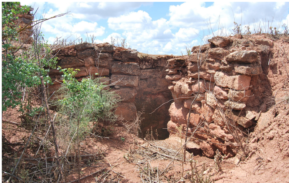
Fig. 3: Final del caz del Molino del Marqués. Foto: autor, 2023.
