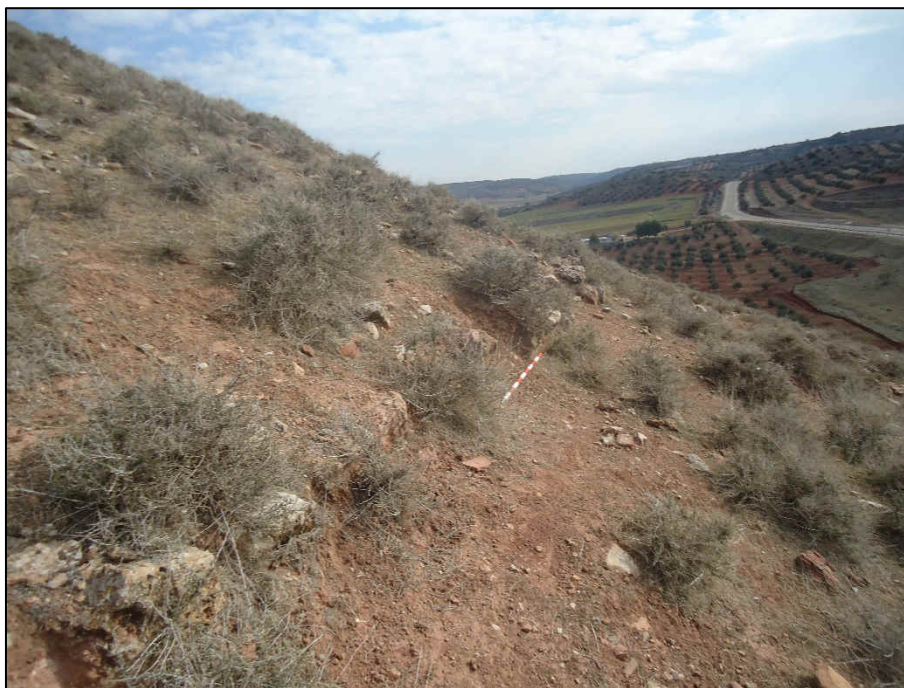
Cimentación del muro que corre a media ladera, cerrando el Sector 1
