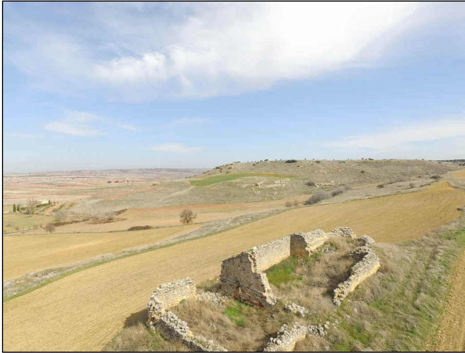
Vista general de la iglesia de Torres con el Sector 1 al fondo de la imagen
