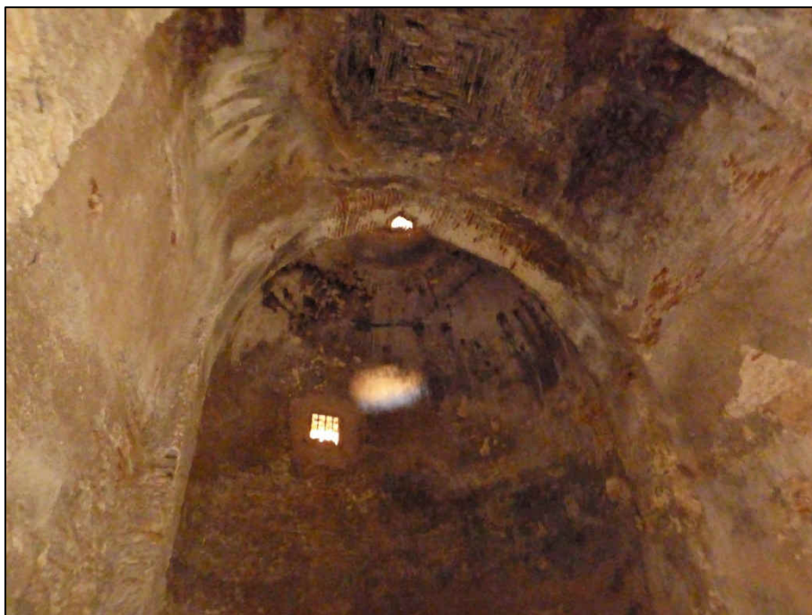
Detalle de la bóveda interior del aljibe
