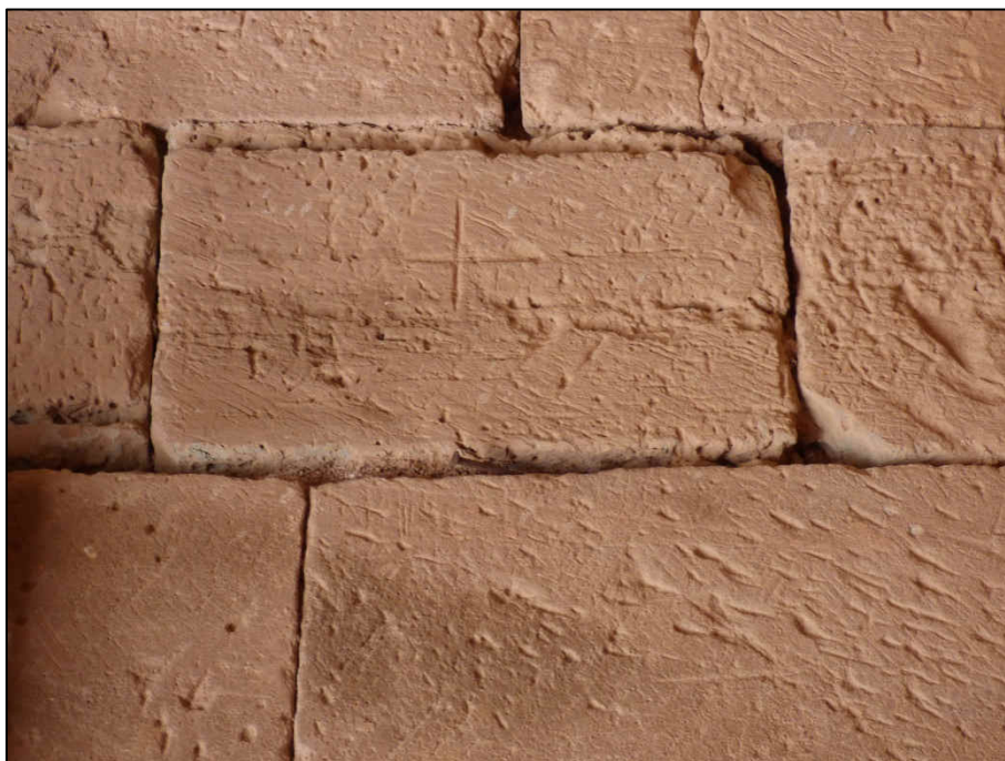
Detalle signo lapidario en la zona de tránsito de la puerta de Hierro
