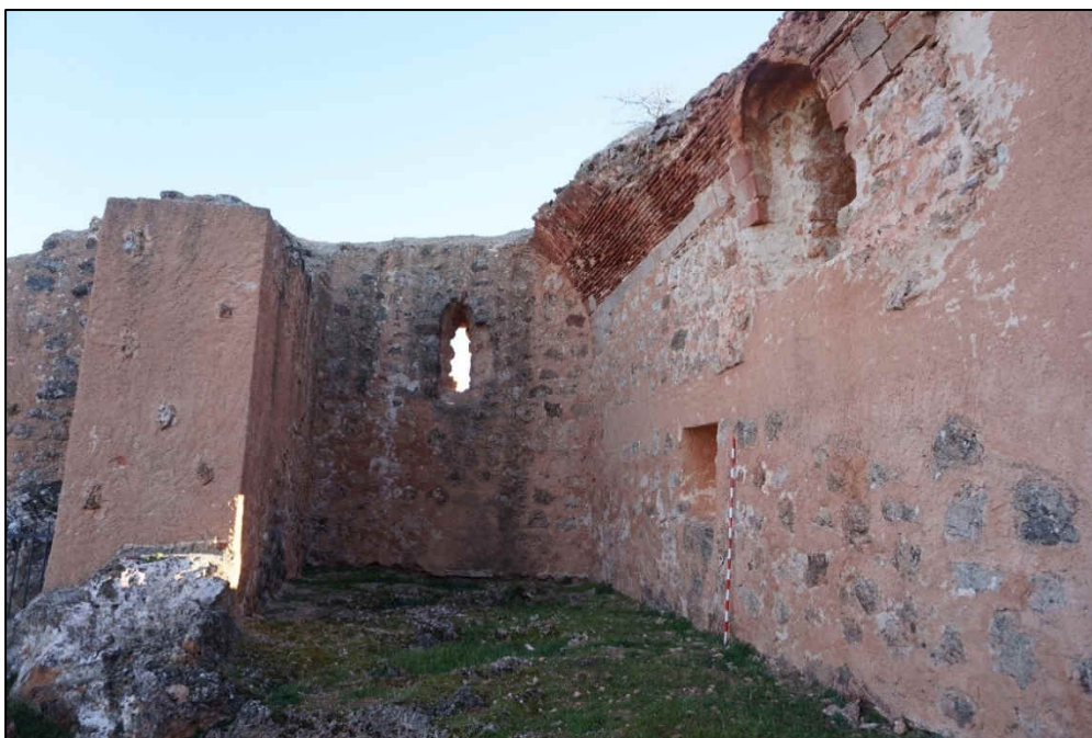
Espacio interno, Sector 2, con el arranque de la bóveda que cubría la cámara
