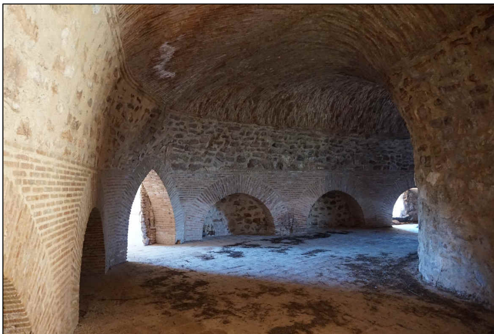
Vista de la bóveda de la primera planta
