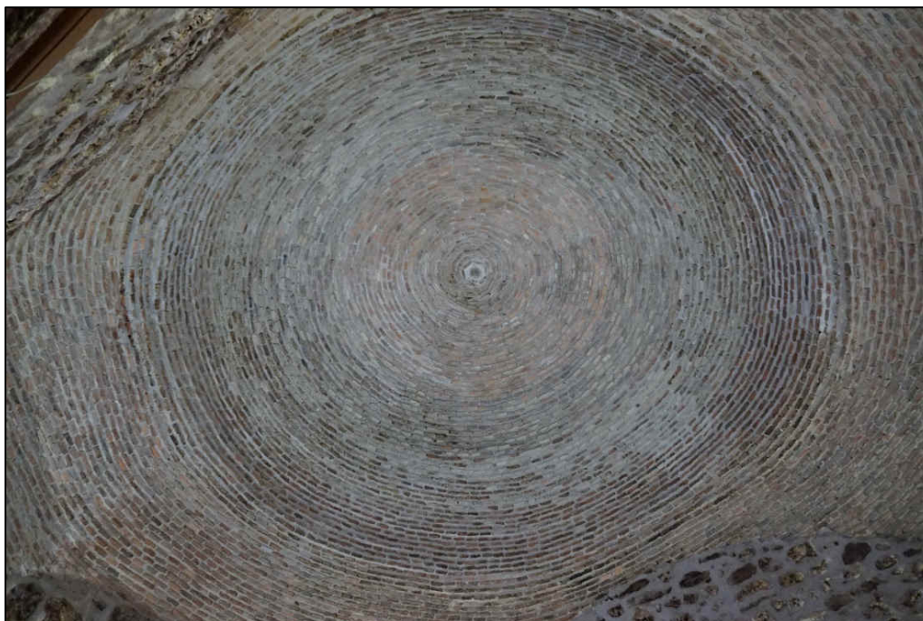
Bóveda de la primera planta o UF 2.
