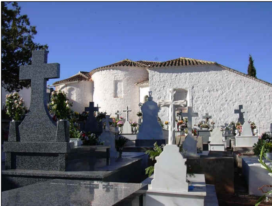
Vista de los restos conservados de la antigua Vicaría de Montiel, actualmente formando parte de la ermita del Cristo
