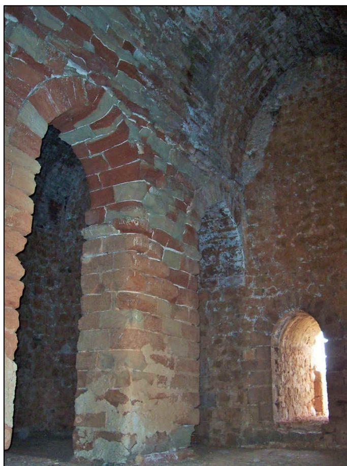
Vista de la arcada y bóvedas de la primera planta (U.F. 2, Ámbito E)
