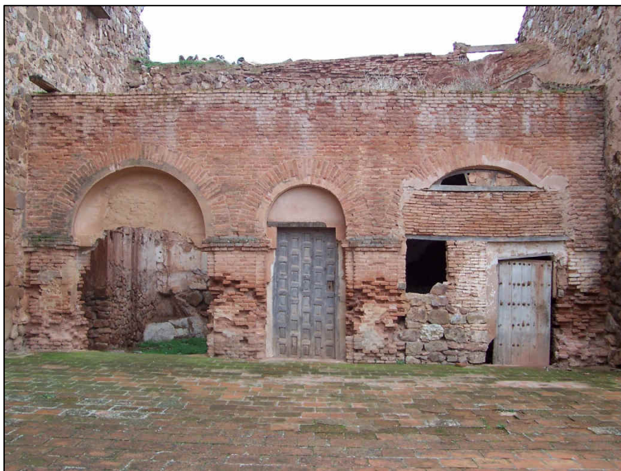
Vista de las cocinas realizadas con la técnica del Ladrill2.Mont
