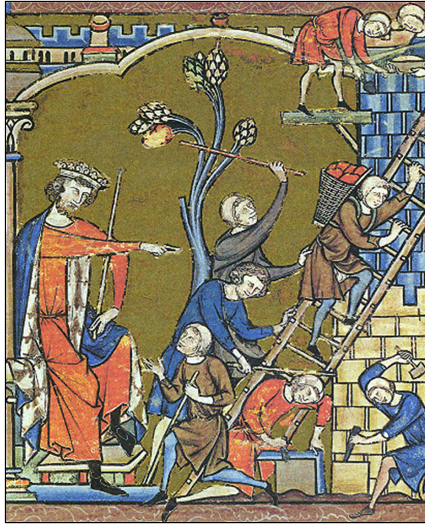
Operario construyendo sobre tablero apoyado en almojajas, miniatura de la Opresión del Pueblo de Israel en la Biblia de los Cruzados 30
