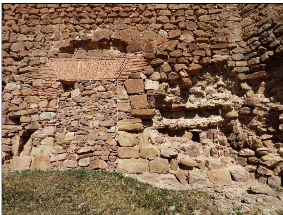
Detalle de la puerta del Río, desmontada y cegada, con los restos del hueco de la tranca
