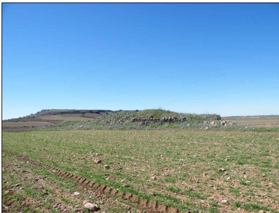
Vista general del edificio, al fondo el río y el Calar de Matillas
