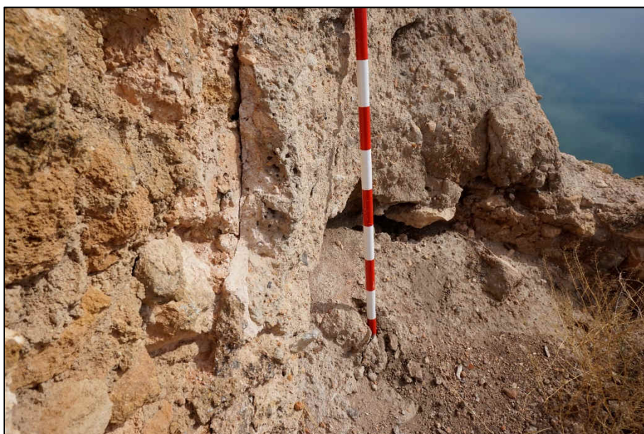
Restos de la muralla de tapial calicostrado en el castillo de Peñarroya, a la que se adosa, a la izquierda de la imagen, otras obras posteriores
