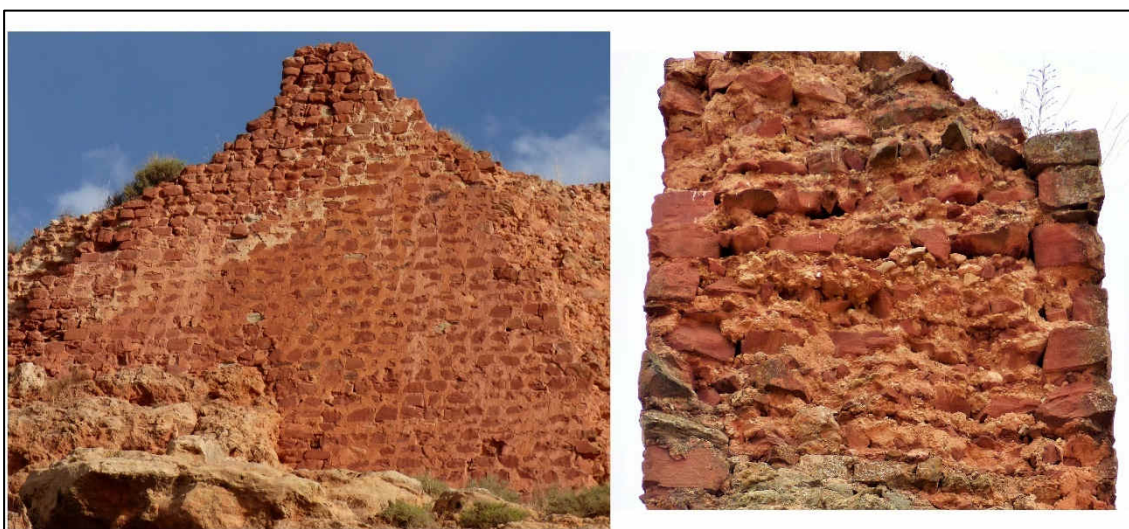
Frente sur de la torre del Homenaje y sección del muro con el sistema constructivo del Silla2.Est
