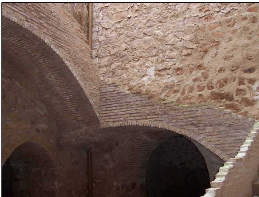
Escalera interna de la torre del Homenaje, realizada mediante el Ladr3.Mont
