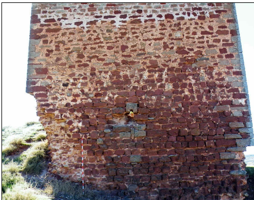
Torre 9, con los encadenados de sillares realizados en Sille1.Est
