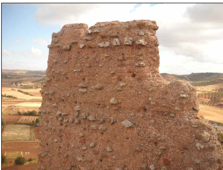
Detalle del Tap1.Est en la Torre 1
