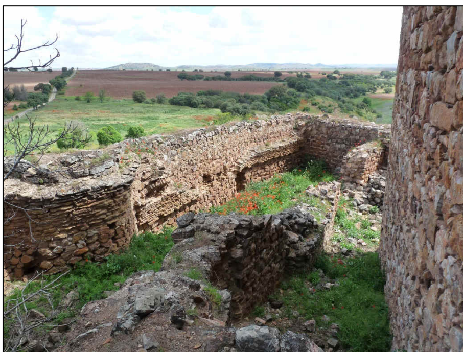
Edificio 6 o caballeriza ocupando gran parte de la liza, en su costado septentrional
