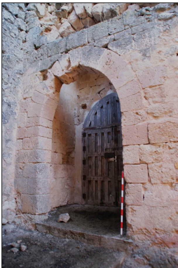
Puerta de la muralla en cremallera de Uclés, con el uso de la fábrica de sillería
