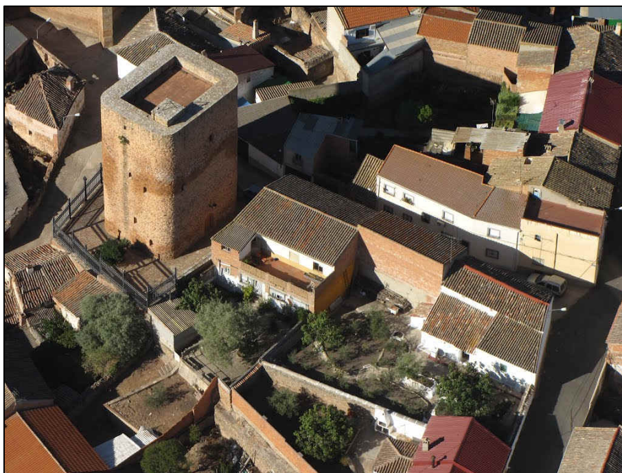
Vista general de la fortaleza con el vecindario adosado a la misma
