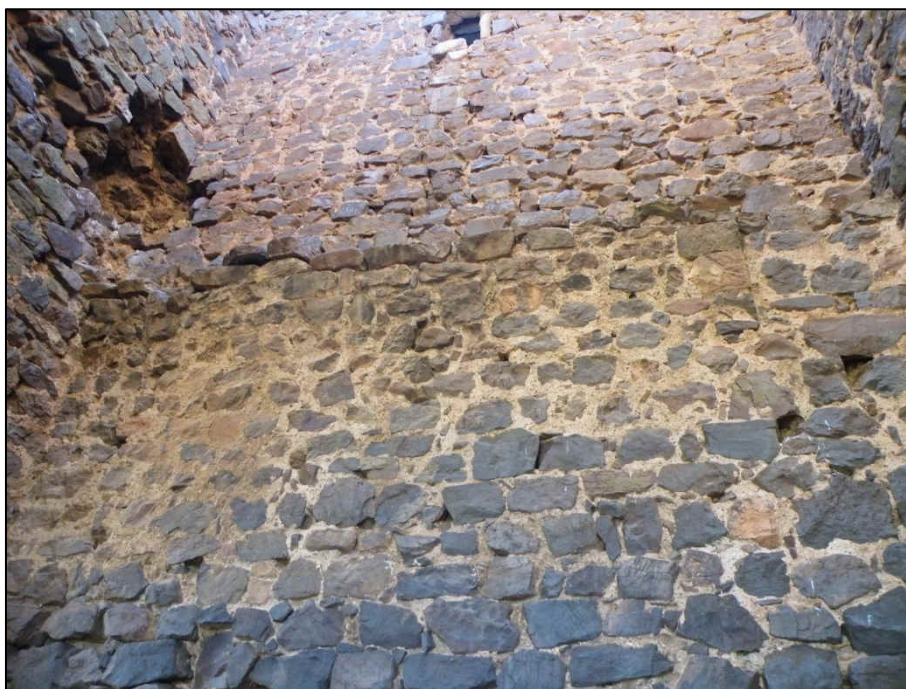
Interior de la torre, restos de la escalera de acceso a la primera planta y arranque de la bóveda
