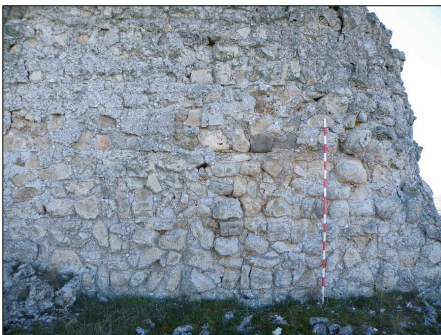
Paramento de tapial de mampuestos en la torre de Fuente del Pez
