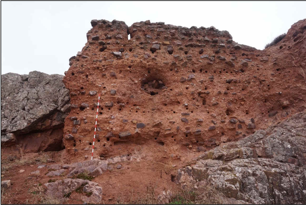
Vista del Lienzo 2, construido mediante Tap1.Ezn
