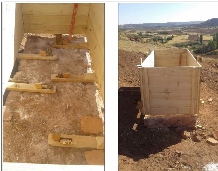
Detalles del cajón de tapial realizado en el castillo de La Estrella
