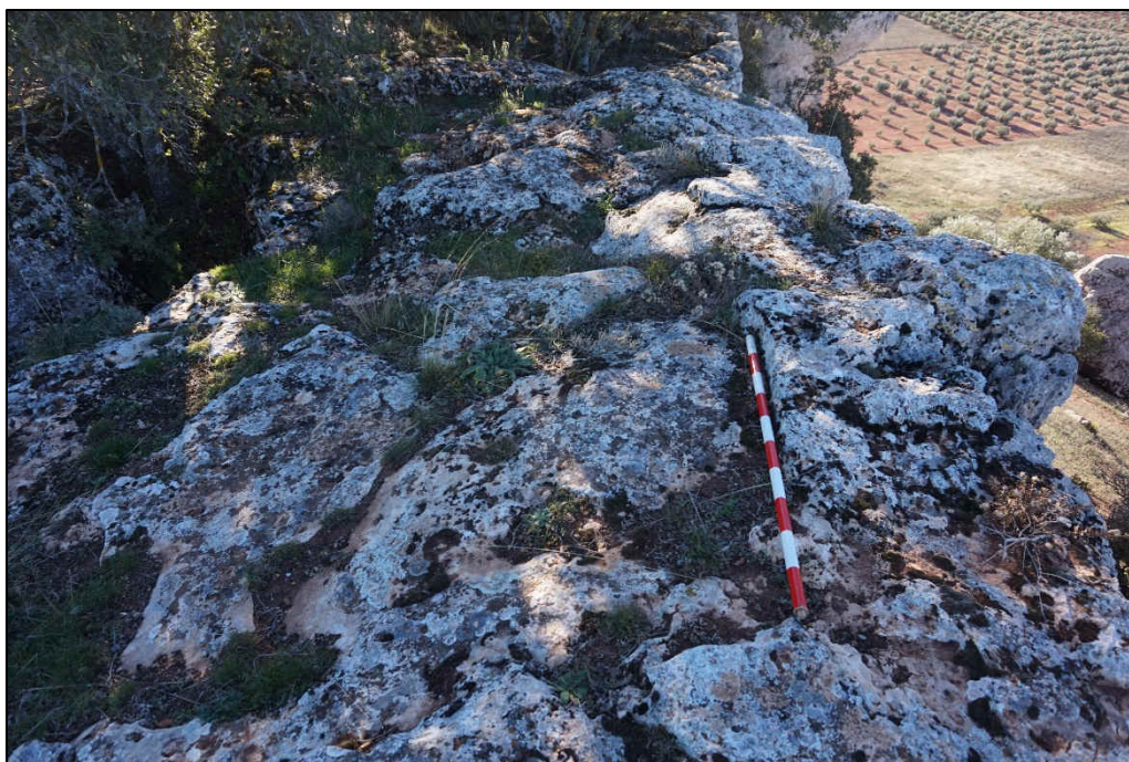
Vista de los retallados en la roca para asentar el muro perimetral
