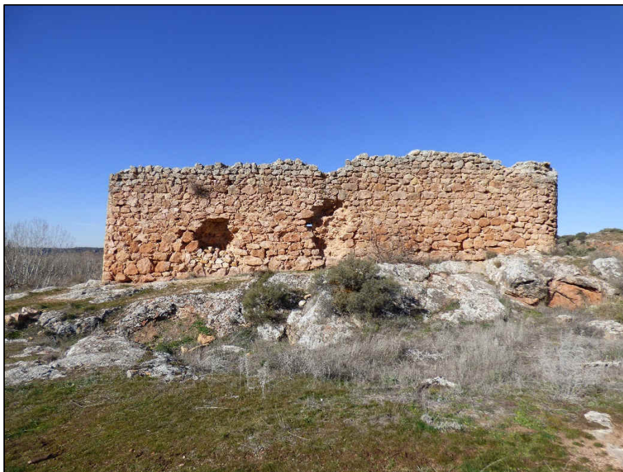
Vista general de la Torre 1 desde el sur
