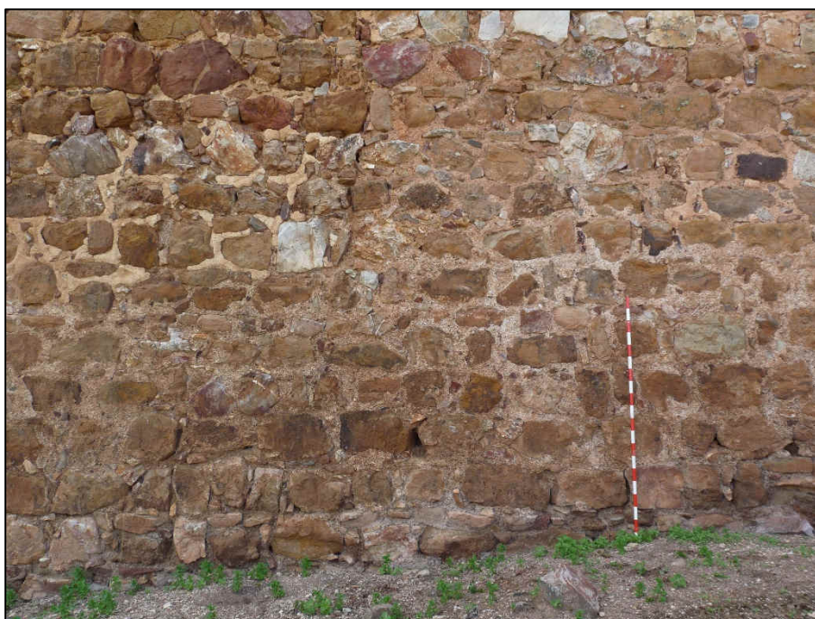
Detalle del Lienzo 18 donde se aprecia la construcción en muros escalonados
