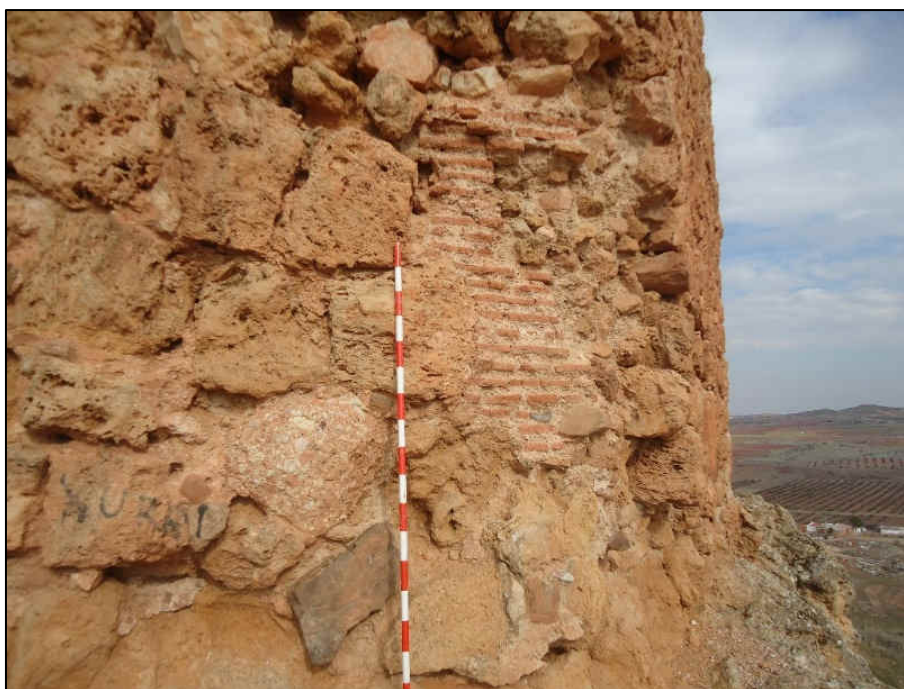
Lienzo 4, detalle del arranque de la bóveda de ladrillo
