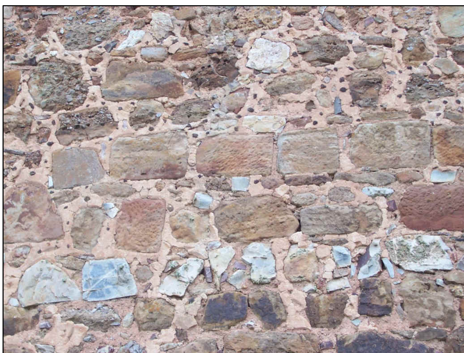
Detalle del Silla4.Mont con el revestimiento y la presencia de escorias, en este caso en el Lienzo 18
