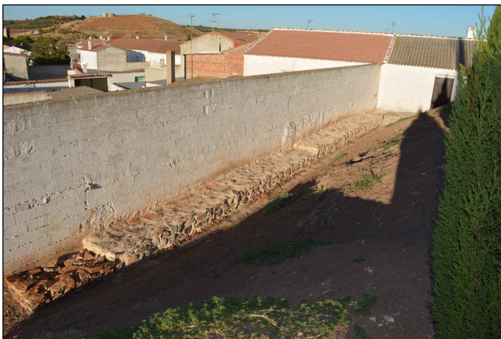
Vista de uno de los posibles muros de la fortaleza reaprovechado como cimiento de una vivienda actual
