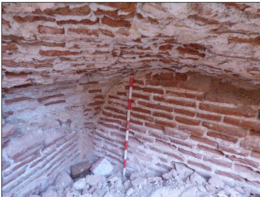
Bóveda del aljibe, la única conservada aún en pie, realizada con Ladr1.Est
