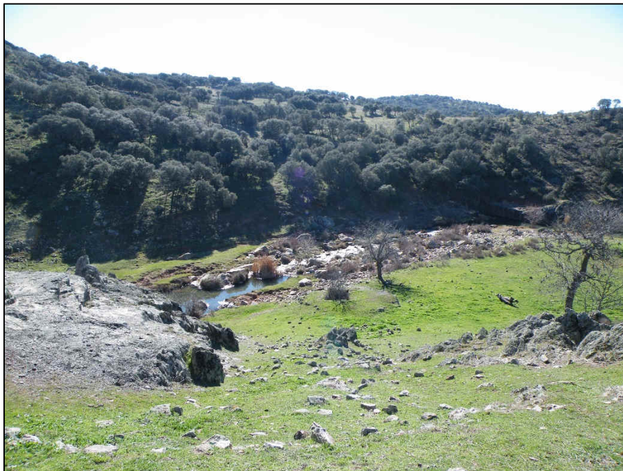
Vista general del sistema de acceso y la estructura hidráulica al fondo
