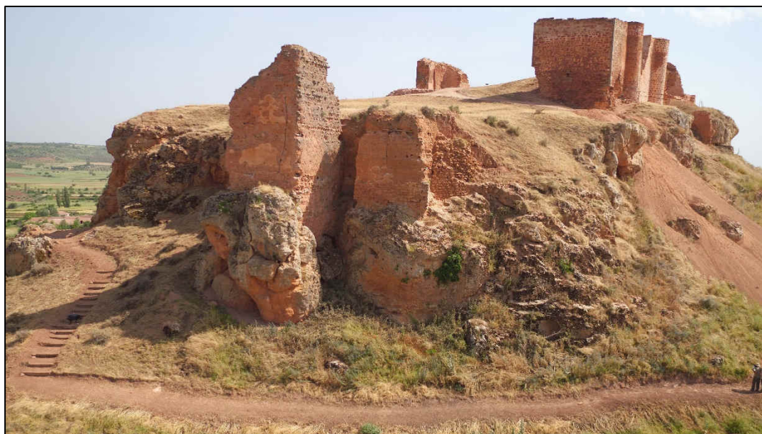
Vista general del frente occidental del castillo de La Estrella
