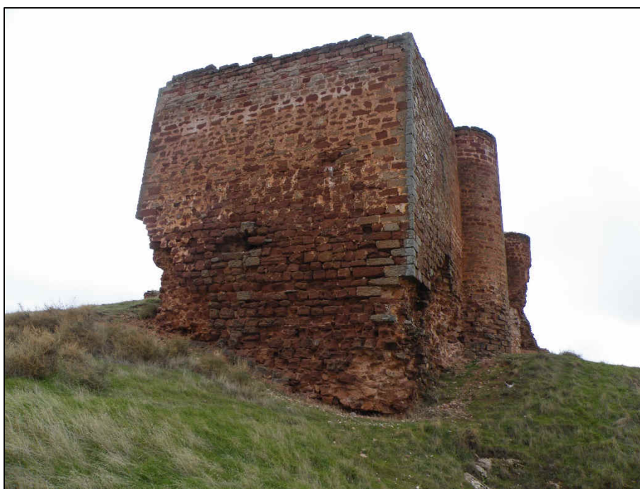
Torre 9, construida en gran parte mediante el Silla2.Est
