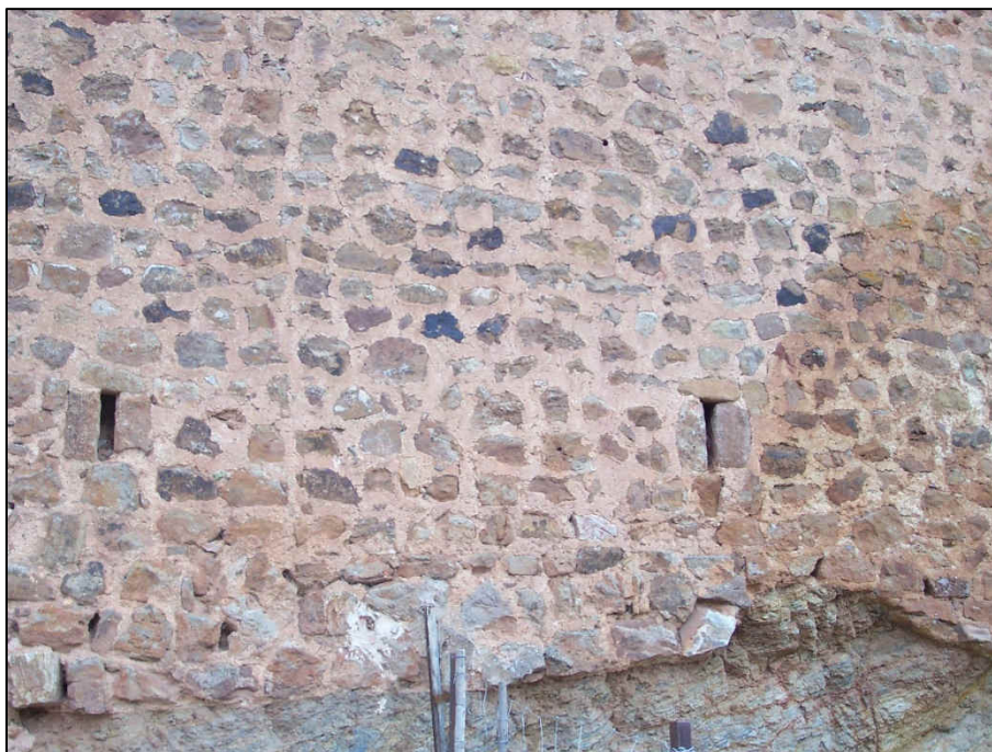
Vista del conjunto de saeteras realizadas en Silla1.Mont en el Lienzo 1
