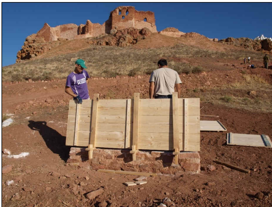
Reproducción de un tapial imitando el modelo del Tap2.Est, en especial el sistema de carpintería 62
