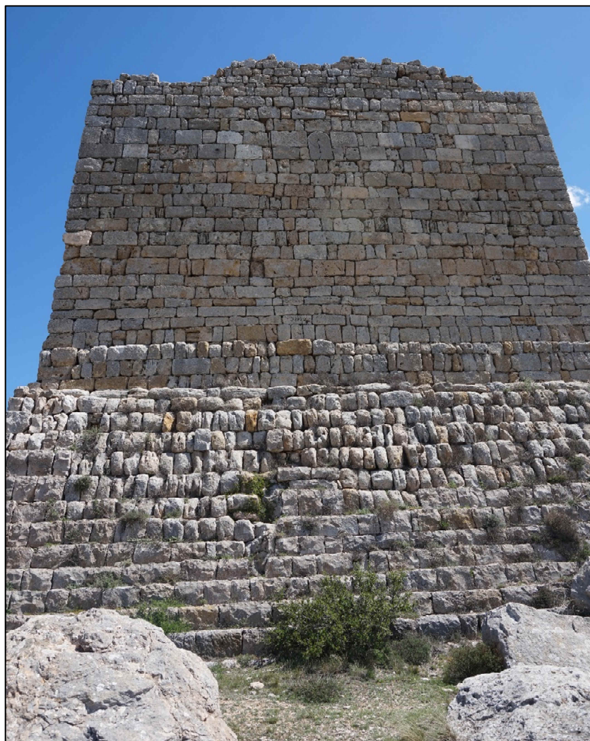
Torre del Espolón en el castillo de Gormaz (Soria) con la fábrica de sillares y el aparejo oficialista del califato Omeya
