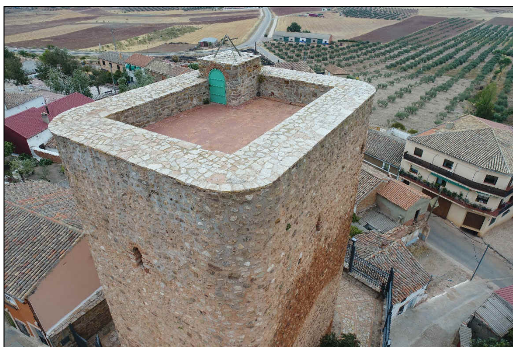
Vista de la terraza en la actualidad, con el sistema de acceso
