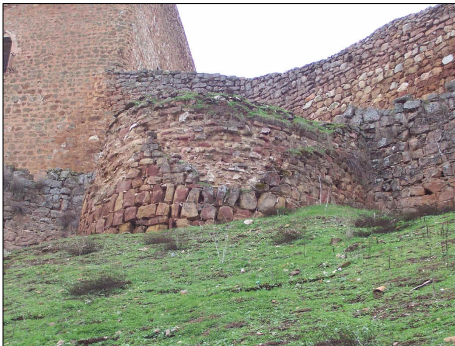
Vista de la Torre 4 erigida mediante la Mamp6.Mont
