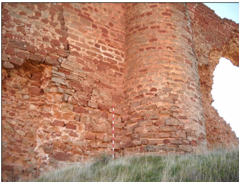
Silla4.Est, detalle de la Torre 10 cosiéndose en la Torre 9
