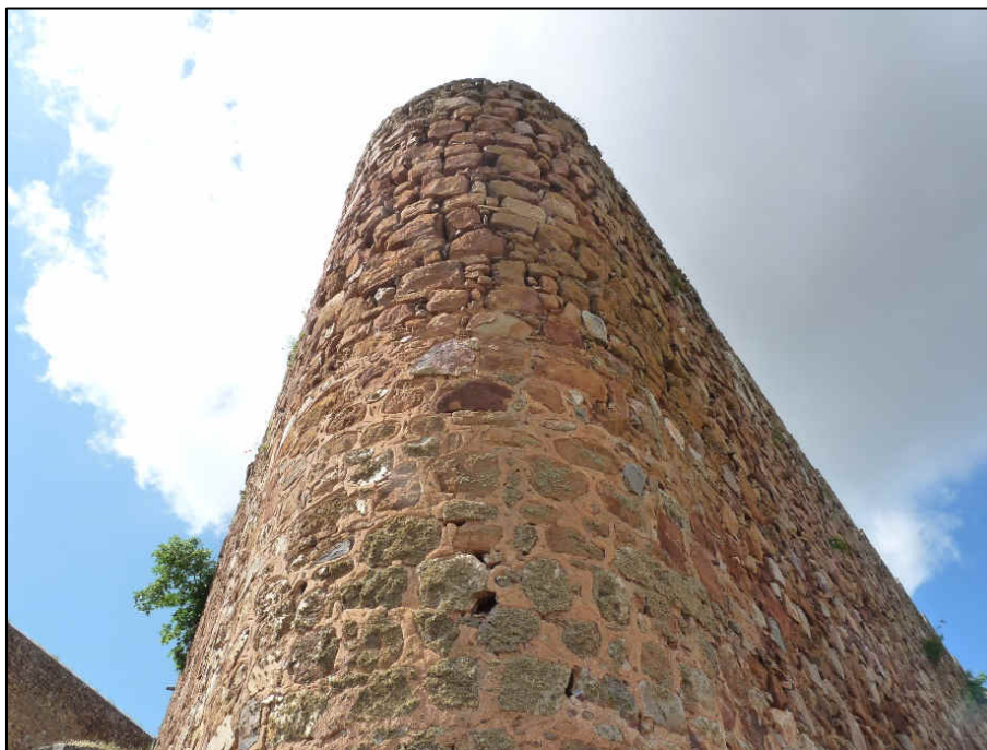
Vista del paramento con los restos del revestimiento
