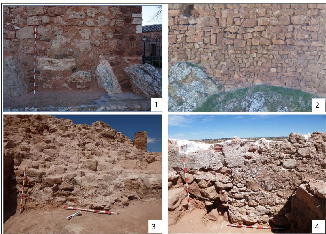
Reparaciones en los paños de los castillos de Albaladejo (1), Montizón (2) y Montiel (3, 4), documentadas en los libros de visita
