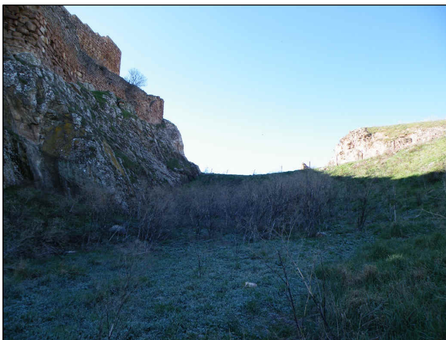
Vista general del foso en la zona no amortizada
