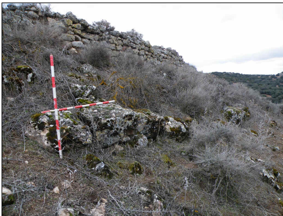
Vista de los restos del antemuro y la cerca sobre el mismo
