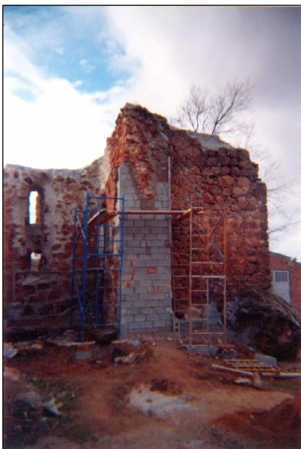
Proceso de construcción de los muros de bloques de fibrocemento
