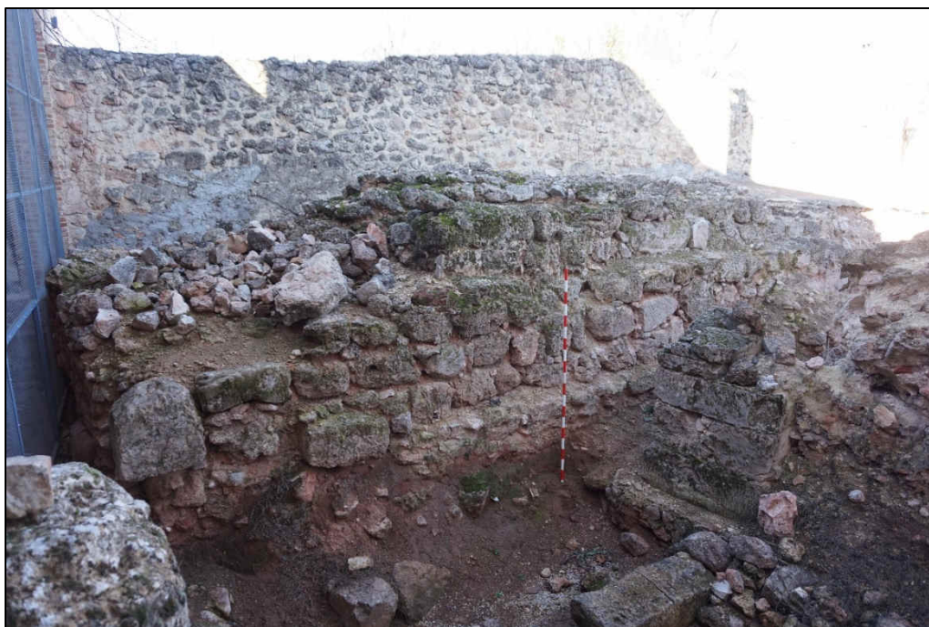
Vista general de los restos de la Torre 2
