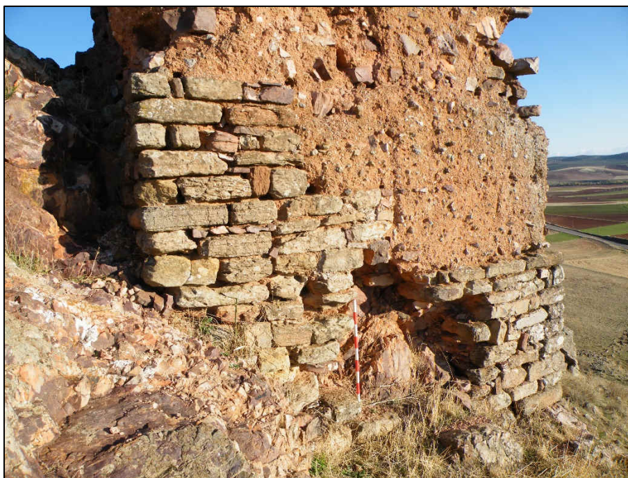
Vista del sillarejo que forma el basamento occidental de la Torre 7
