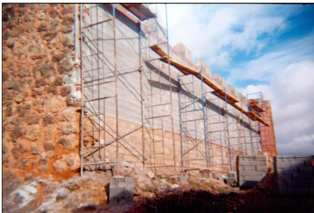
Proceso de construcción de los muros de bloques de fibrocemento
