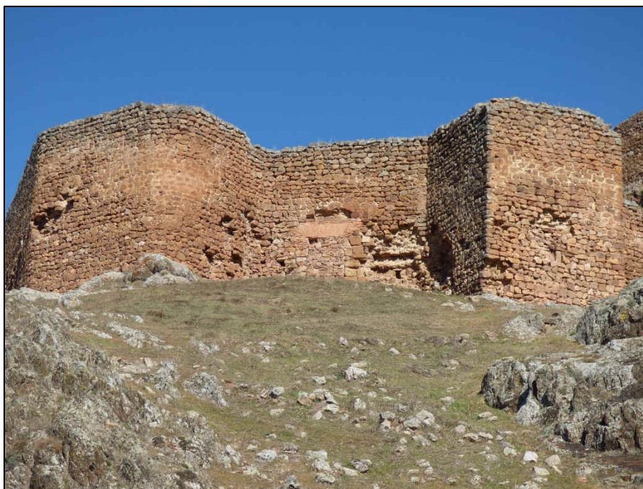
Vista de la rampa de acceso hasta la puerta del Río
