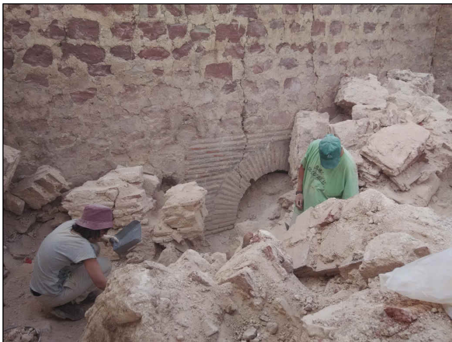
Proceso de excavación del derrumbe de las bóvedas de la torre del Homenaje del castillo de Montiel
