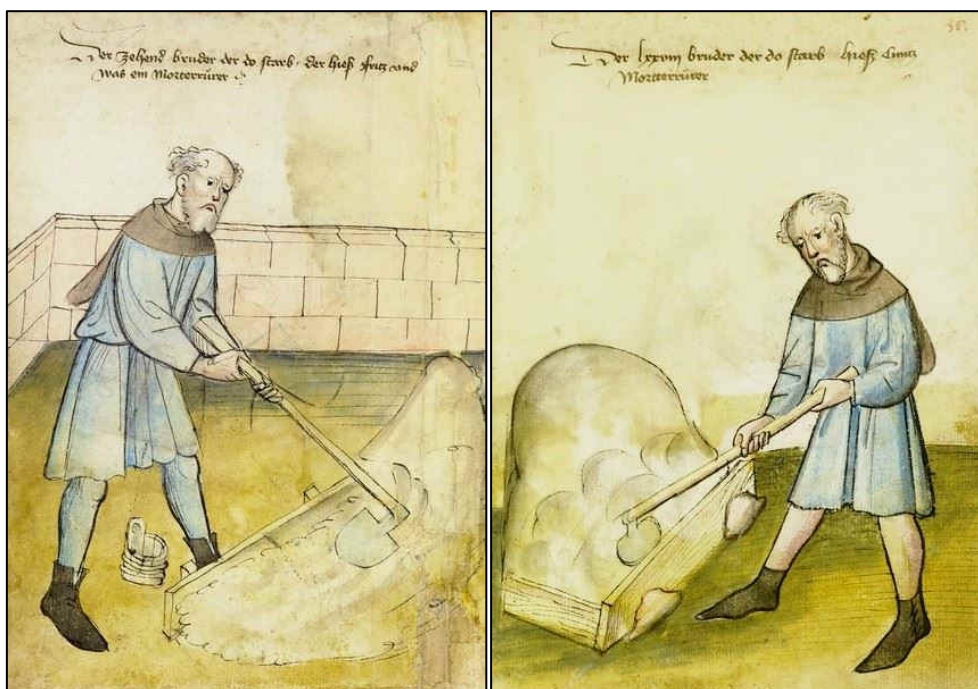
Procesos de elaboración de la cal y yeso a pie de obra 12
