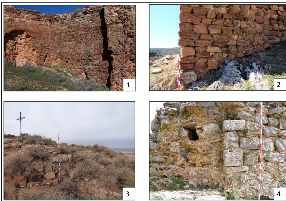
Fábricas en sillarejo de esta etapa en los castillos de Montiel (1), Montizón (2), Alcubillas (3) y Rochafrida (4)
