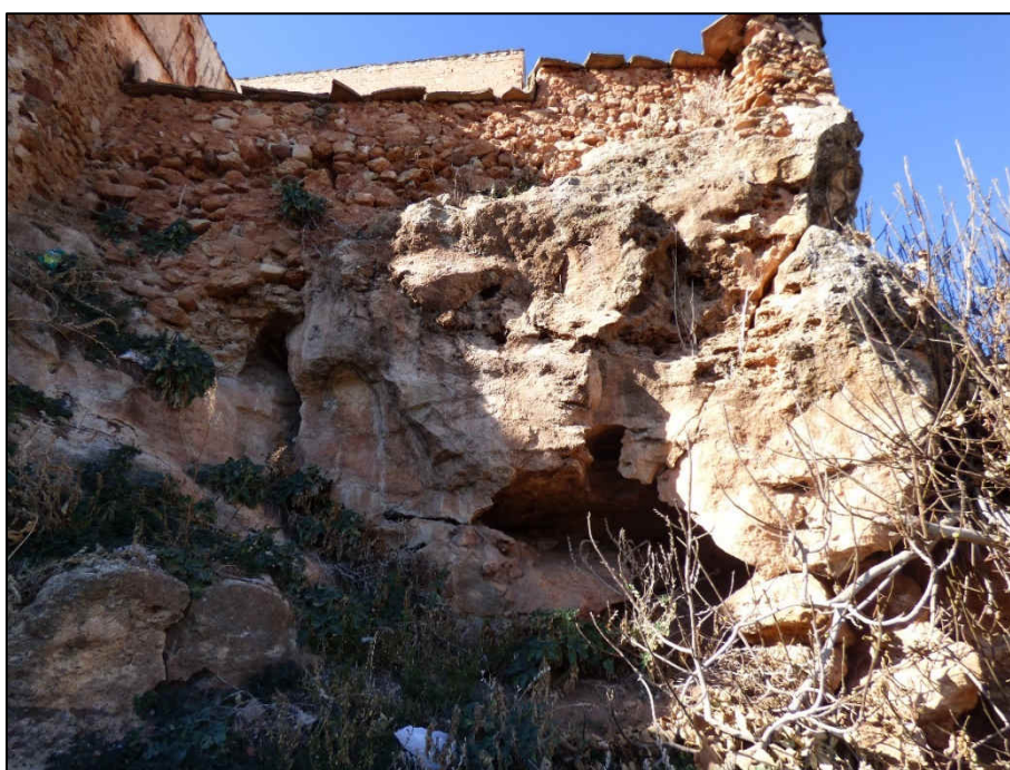
Vista del antemuro que forma el Sector 1, oculto parcialmente bajo la tapia de un corral
