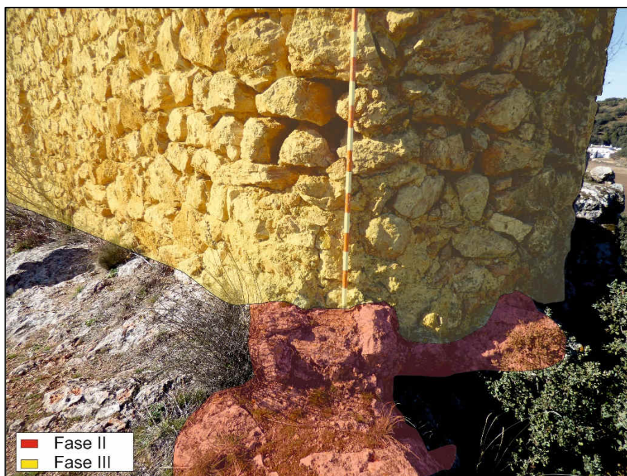
Detalle del apoyo de la Torre 1 sobre el Lienzo 1
